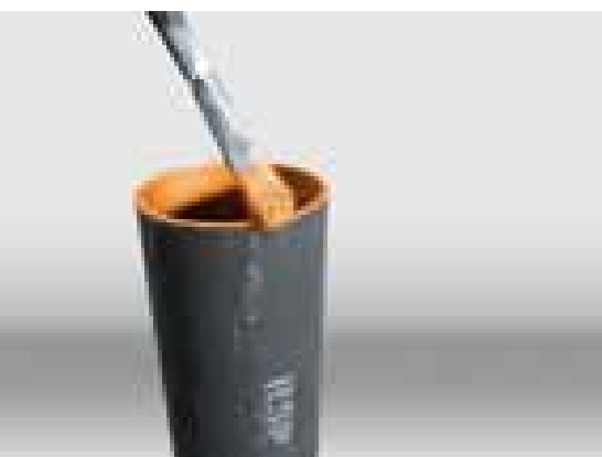
Перед соединением края отреза следует обработать защитным покрытием, которое можно нанести кисточкой или спреем (DIN EN 1610 8.5.5)
